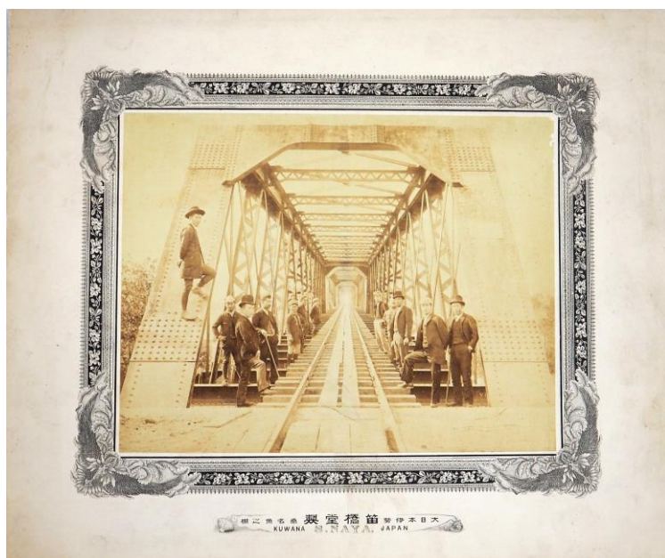
この写真は揖斐川橋りょう竣工記念写真で、 撮影したのは桑名の笛橋堂写真館である（鉄道総合技術研究所所蔵）
