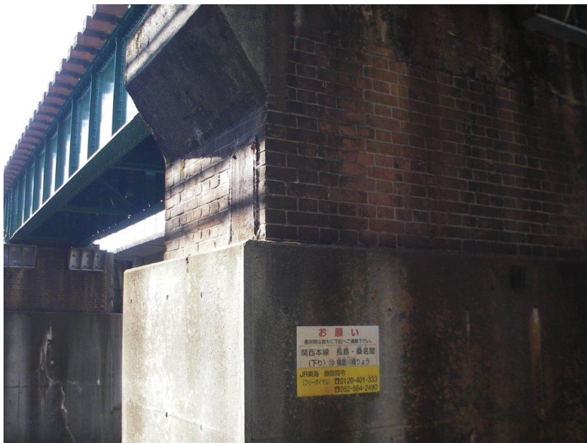
レンガ積みの播磨川橋梁
