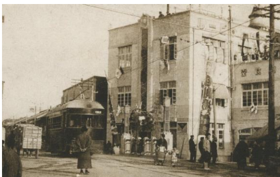
寺町の角にあった旭ビルの前を通る電車
