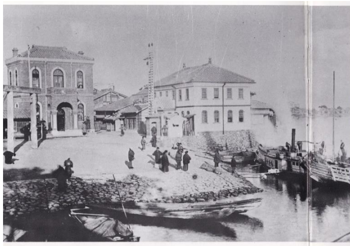
明治 19 年頃の七里の渡し場、警察署と電信局（レンガ造り）
