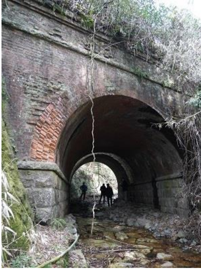
① 鳥谷川斜拱渠
