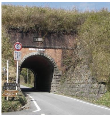
⑤ 大和街道架道橋
