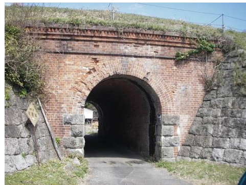
④ 165号架道橋
