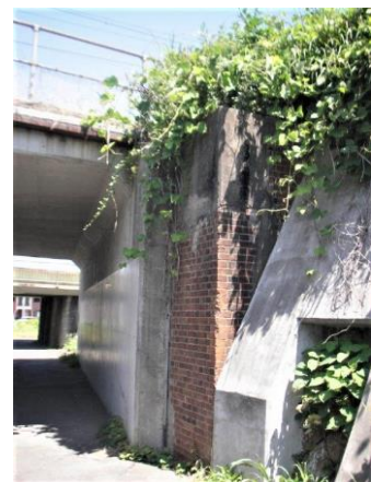
現在も一部が残るレンガ積み土台 （安永宮西町）
